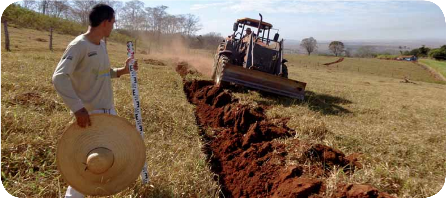
Curvas em nível em processo de construção pelo projeto Pé de Cerrado
