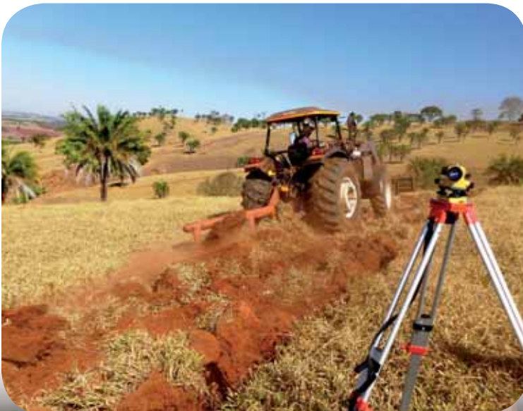
Curvas em nível em processo de construção pelo projeto Pé de Cerrado
